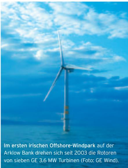
Im ersten irischen Offshore-Windpark auf der Arklow Bank drehen sich seit 2003 die Rotoren von sieben GE 3,6 MW Turbinen (Foto: GE Wind).
